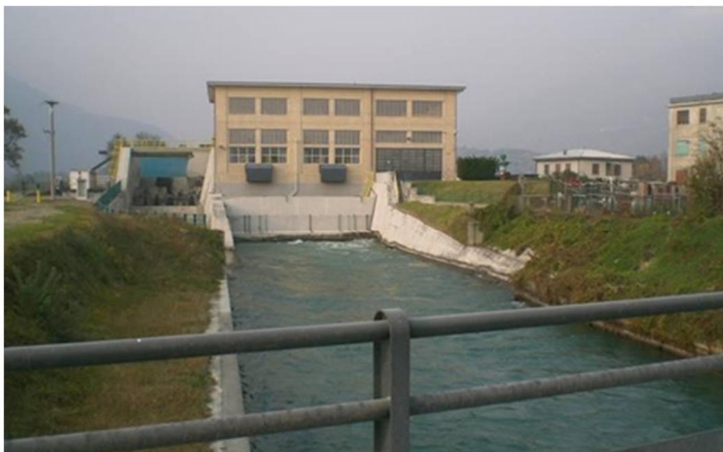
Edificio della centrale
