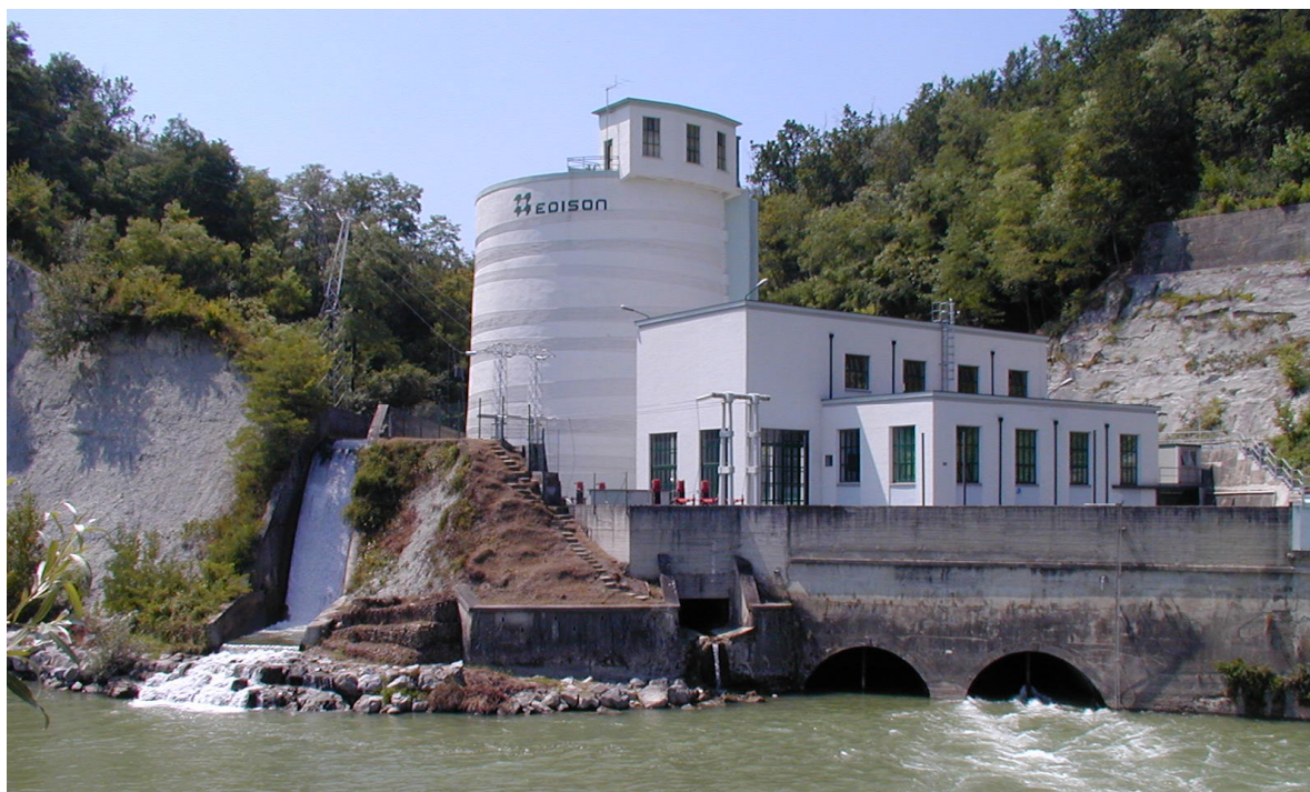
Impianto di Farigliano
