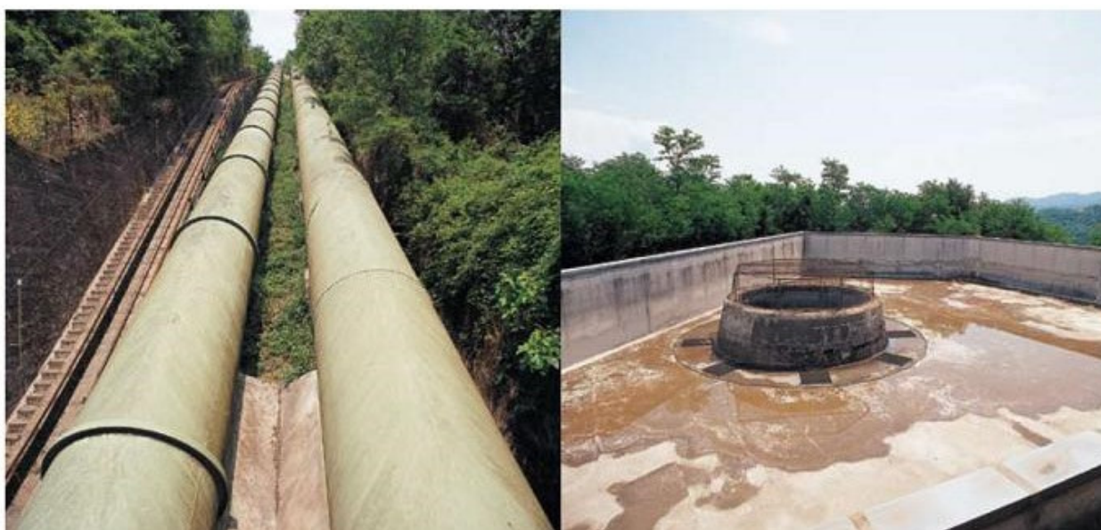
Impianto di Tegna
