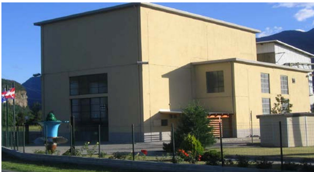
Edificio della centrale
