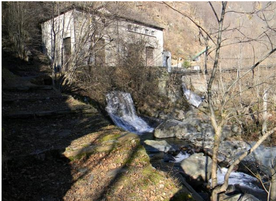
Canale di consegna impianto di Montescheno
