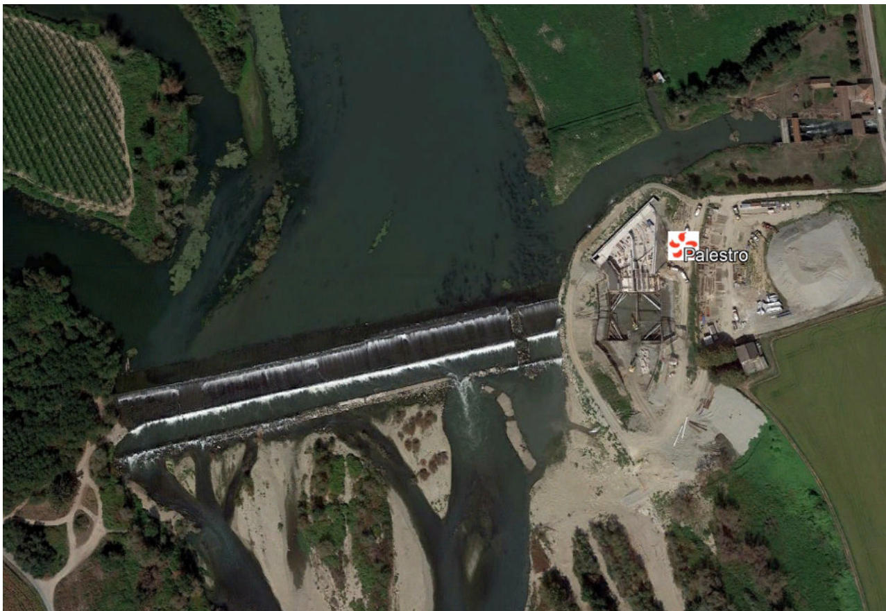
Impianto di Palestro (fonte: Google Earth)
