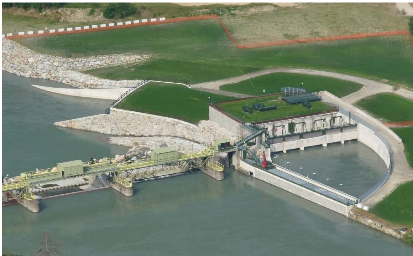
Impianto di Tavagnasco (Montestrutto)
